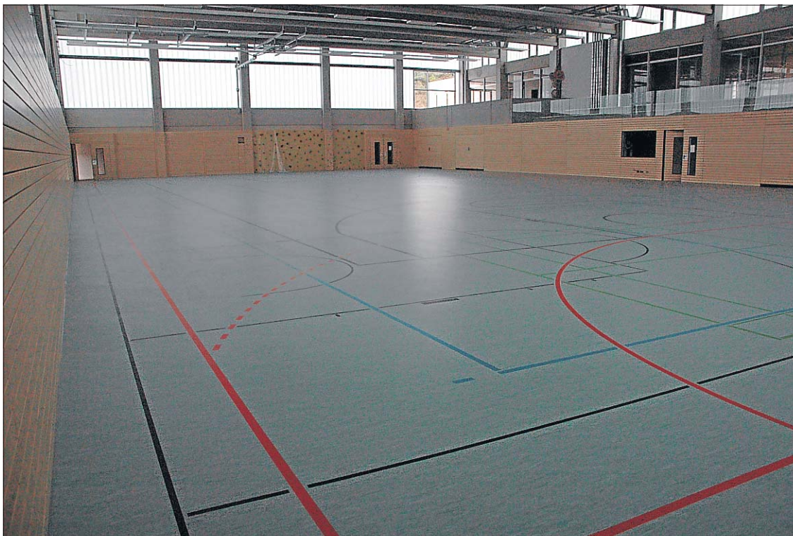
Die neue moderne Sporthalle, direkt an die „Maison relais“ angebaut, ist bereits fertiggestellt. Lediglich die verschiedenen Sportgeräte müssen noch installiert werden.
