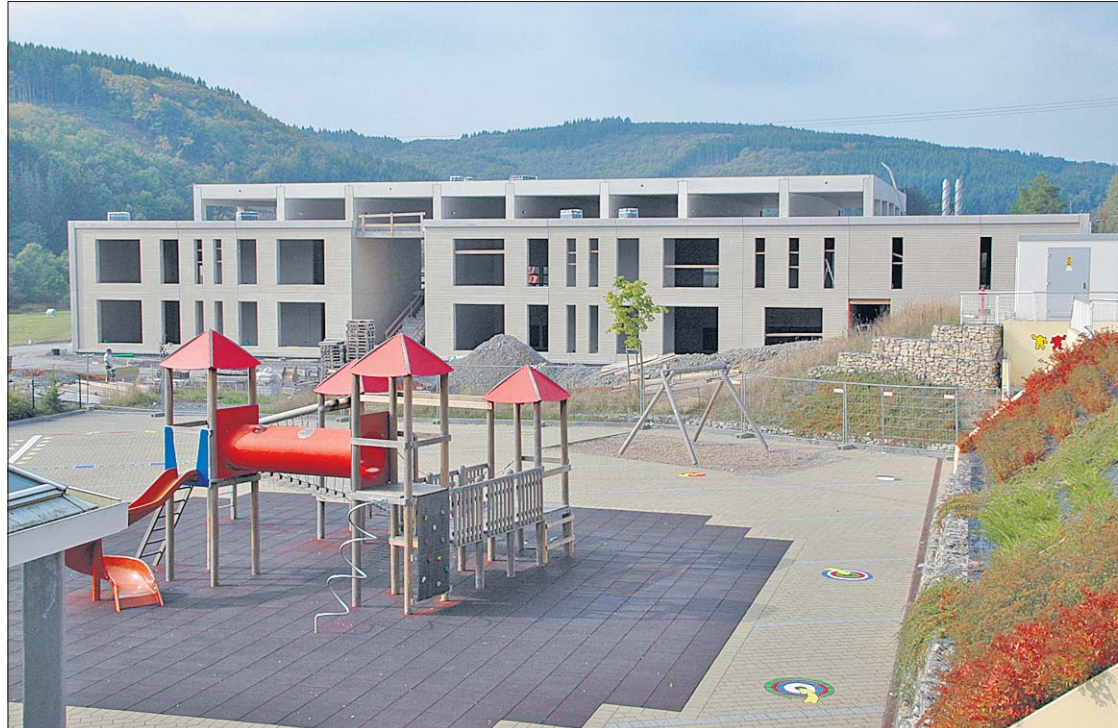
Die derzeitigen Arbeiten konzentrieren sich auf Abdichtung und Isolierung des Betondachs.
